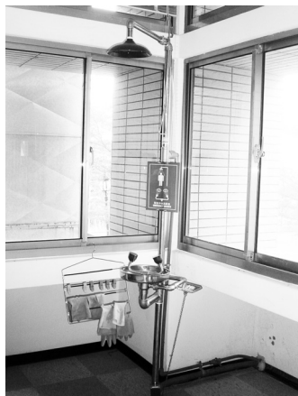
緊急沖水設備 (emergency safety wash station) : 防止實驗過程中發生危害時，可做為緊急沖水使用。
